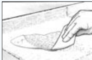
Σχήμα 29 Απλώστε το εποξειδικό μίγμα πάνω στην επιφάνεια του υφάσματος με ένα πλαστικό μάκτρο.
