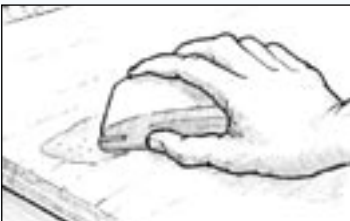
Kuva 23 Hio kovettunut tasoitusaine haluttuun muotoon.
