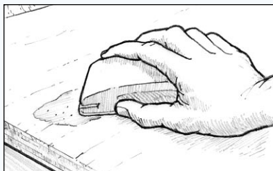
Figur 23 Slipa spacklet jämnt med omgivande yta.
