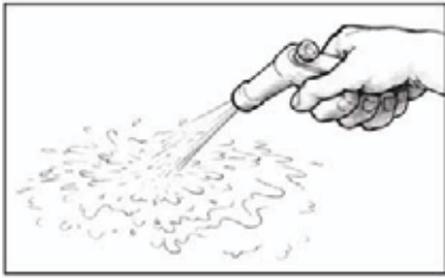
Рис. 33. После шлифовки промойте поверхность пресной водой.
