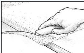
Kuva 25 Leikkaa ylimääräinen kangas epoksin hyytelöidyttyä, mutta ennen kuin se kovettuu kokonaan.
